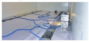
Microonde: asciugatura di plinti di fondazione, pavimenti di terrazzi, tetti piani ecc., ma anche di pavimenti continui e isolamenti, pareti e soffitti
